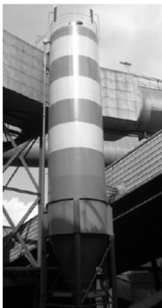
Рис. 3. Отдельно стоящий накопительный бункер 150 м<sup>3</sup>
