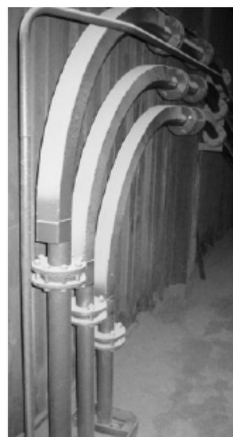
Рис. 7. Основные транспортные трубопроводы к струйным распределителям
