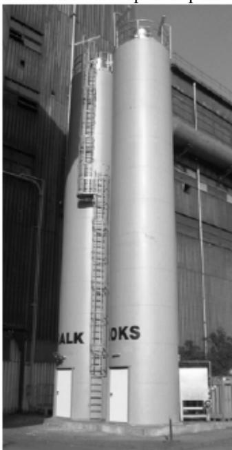
Рис. 2. Накопительный бункер с опорой в виде обечайки
