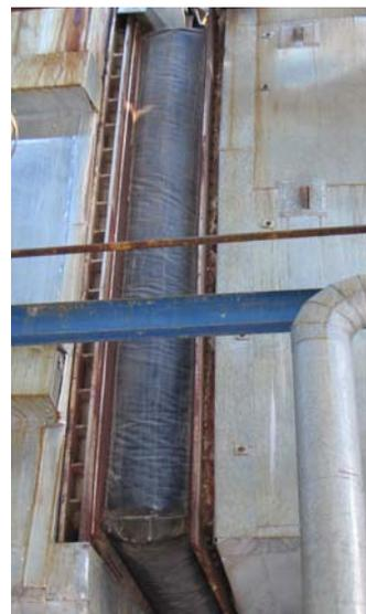
Рис. №4. Тканевый компенсатор с применением газоплотных слоев на основе фторопласта.
