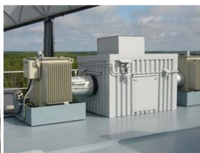
Трансформатор управляется микроконтроллером **Micro Kraft**, встроенном в **Шкаф управления питанием электрофильтра** .
