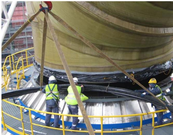
Рис. №2. Монтаж компенсатора
