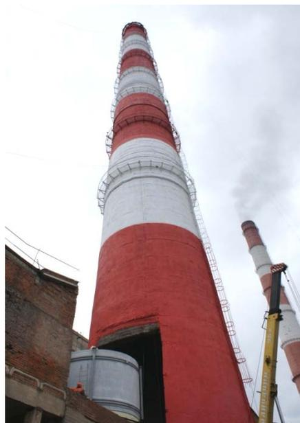
Фото 1. Монтаж газоотводящего стеклопластикового ствола  $D=5.2$  м дымовой трубы №1  $H=150$  м Кировской ТЭЦ-4
