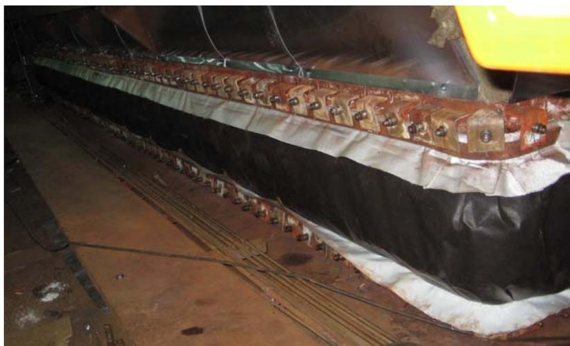
*Рис. №1. Компенсатор конвективной шахты котла*
