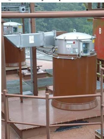
Рис. 6. Фильтры INFSTAUB, установленные на бункерах.
