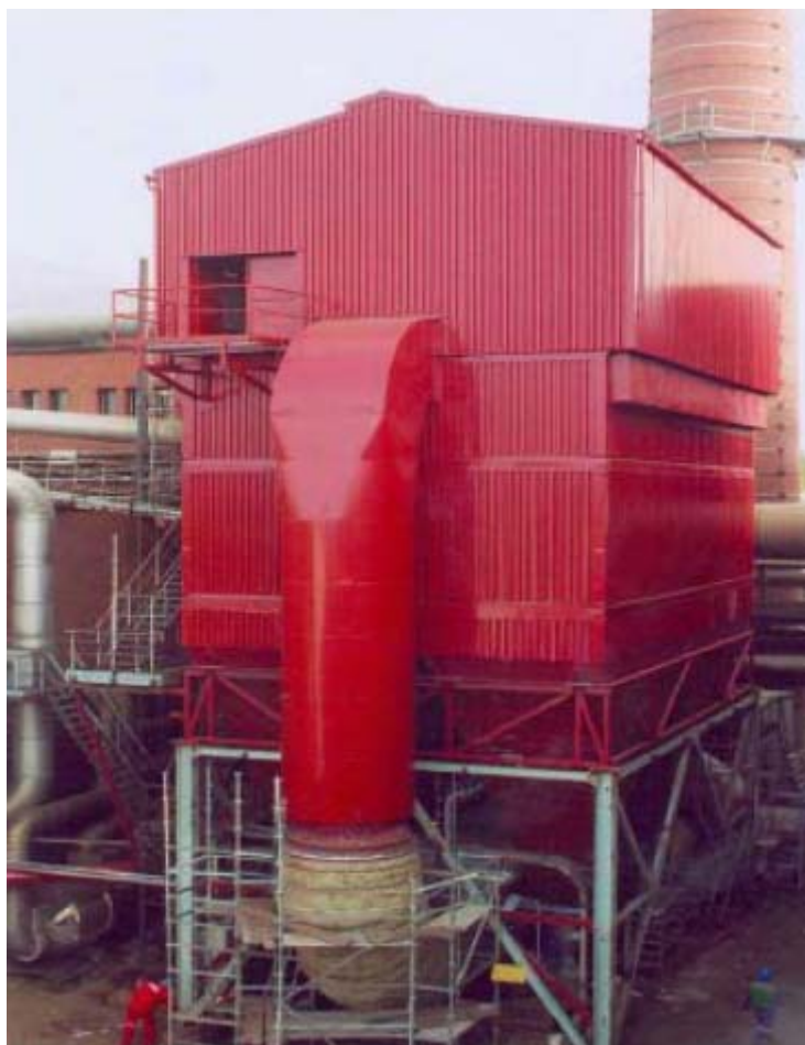
Рис. 2 Рукавный фильтр Varitex 4xVT330-4,9/30, производительностью 156550 м 3 /час, рабочая температура 140-150 °С. Инжиниринг – INDUSTRI TEXTIL Job, материал рукавов – GORE TEX (Официальный представитель в России – ООО «Индастриал Восток Инжиниринг»)
