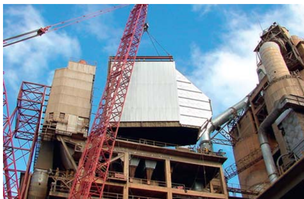
Рис. 3. Подъем двух секций электрофильтра
