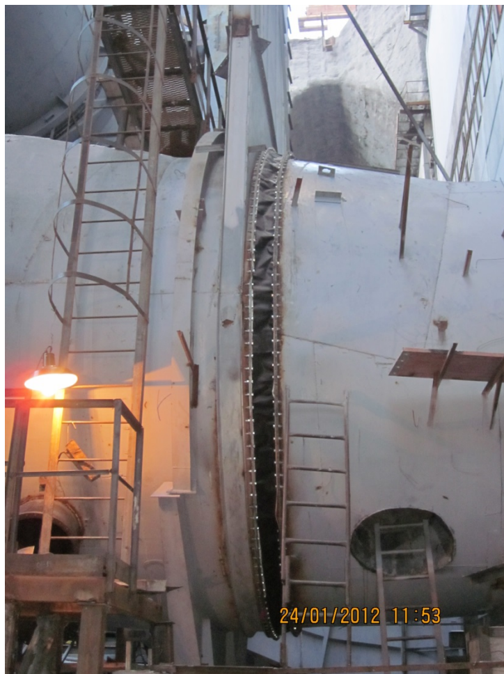
Рис. 4. Смонтированный компенсатор
