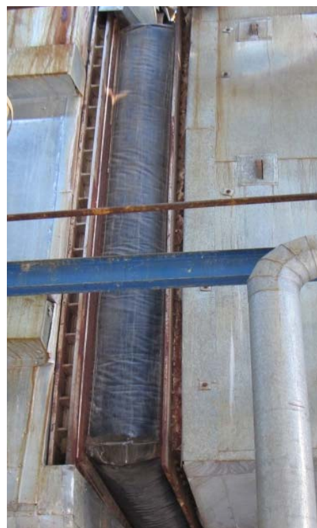
Рис. 3. Тканевый компенсатор с применением газоплотных слоев на основе фторопласта.
