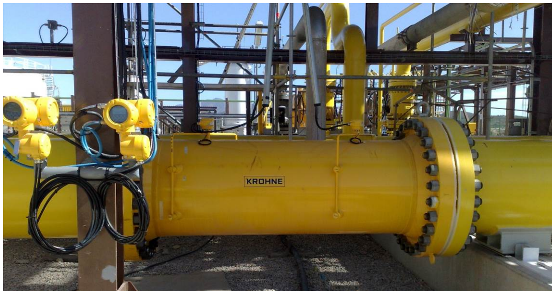
Рис. 5. OPTISONIC 7300 DN750 – дублированный, измерение расхода природного газа.
