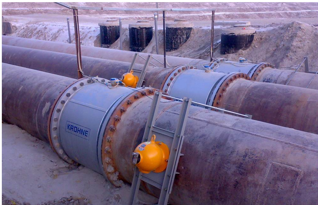
Рис.1 Электромагнитные расходомеры OPTIMASS 2300 DN1200 на измерении расхода пульпы на меднообогатительном комбинате
