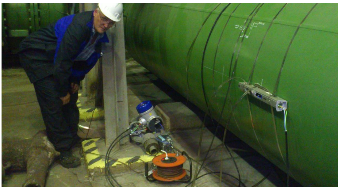
Рис.4 Измерение расхода питающей воды на ОАО «Северсталь» на трубопроводе DN 1420 мм с применением накладного ультразвукового расходомера OPTISONIC 6300
