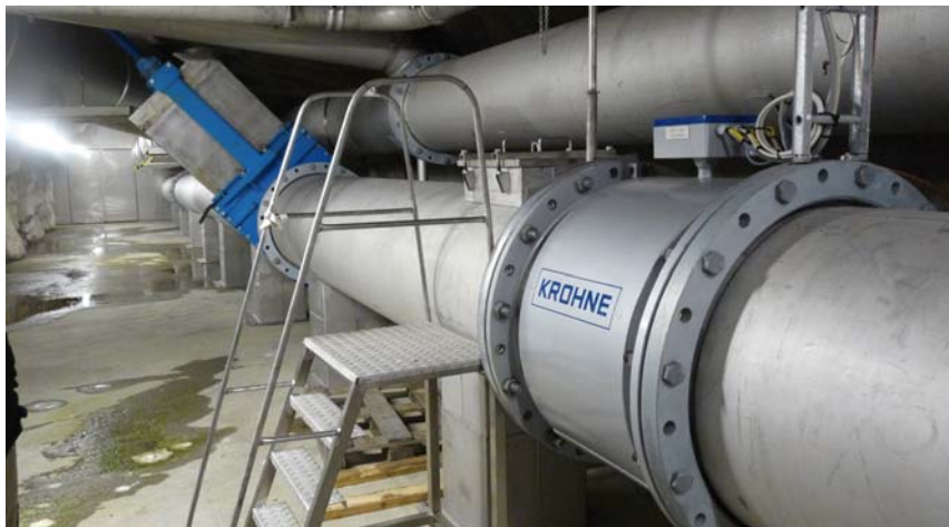
Рис.3 Измерение сточных вод предприятия с применением TIDALFLUX 2300 DN 600
