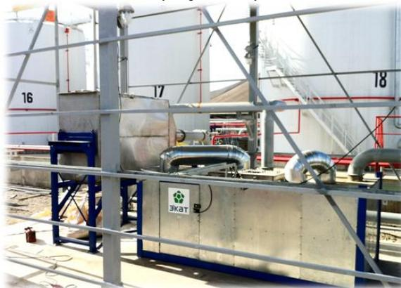
Рис. 3. Общий вид термokatалитической установки очистки газовых выбросов
