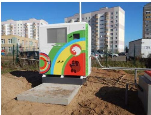
Рис.6. ККР 30МТУ 3614-001-53976876-2014, номинальная производительность 30 м<sup>3</sup>/час. Казань, АЗС группы компаний «Транзит Сити». Рекуперация паров автомобильных бензинов при больших дыханиях резервуарного парка АЗС.
