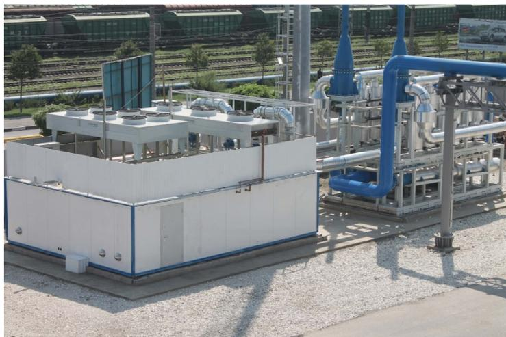
Рис.3. ККР 3000 ТУ 3614-001-53976876-2009, номинальная производительность 3000 м<sup>3</sup>/час.Новороссийск, Новороссийский мазутный терминал. Очисткапаровоздушного потока при большом дыхании резервуаров.
