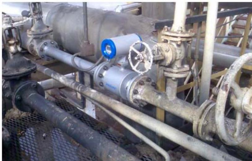
Рис.2 Ультразвуковой 3-х лучевой расходомер на измерении расхода мазута
