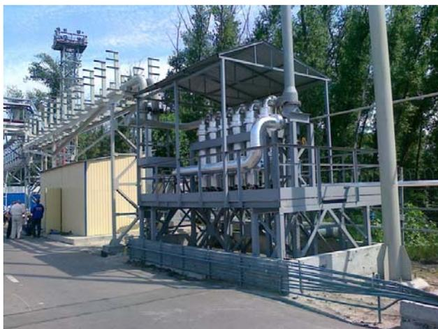
Рис.2. ККР 600 ТУ 3614-001-53976876-2009, номинальная производительность 600 м<sup>3</sup>/час. Ростов-на-Дону, причальный комплекс, Ростовский филиал Новошахтинского завода нефтепродуктов. Рекуперация паров прямогонного бензина при загрузке танкеров.
