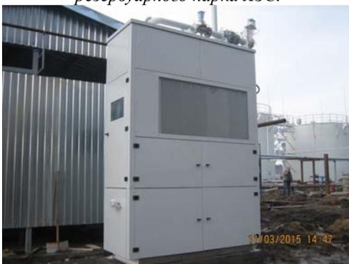
Рис.7 ККР 100М ТУ 3614-001-53976876-2014, номинальная производительность 100 м<sup>3</sup>/час. Иваново, ОАО «Ивхимпром». Рекуперация паров бензинов.
