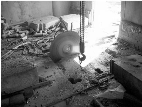
Резка выполняется алмазным инструментом: электрическими или гидравлическими дисковыми пилами, канатными системами, сверлильными установками.
