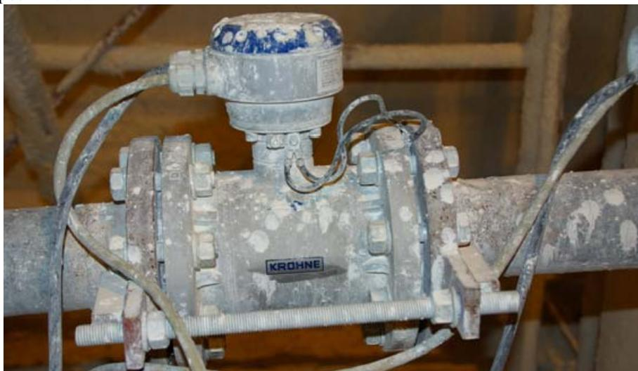
Рис. 3. Электромагнитный расходомер OPTIFLUX 5300 на измерении расхода гидроксида магния с содержанием твердых включений 53%.
