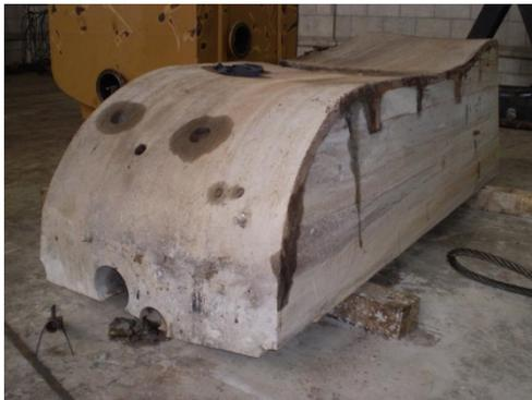
Технология резки алмазным канатом активно набирает популярность в России. Если обычная пила с диском еще может справиться с конструкциями небольшой толщины, то использовать ее для демонтажа,
