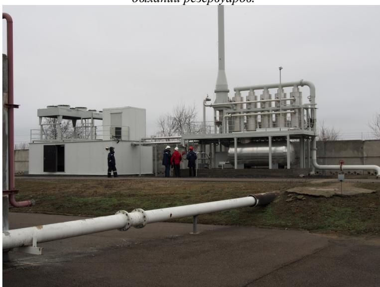
Рис.4. ККР 1000 ТУ 3614-001-53976876-2009, номинальная производительность 1000 м<sup>3</sup>/час.Азов, терминал нефтепродуктов, ЗАО «Азовпродукт». Рекуперация паров автомобильных и прямогонного бензина при больших и малых дыханиях резервуарного парка и при загрузке танкера.
