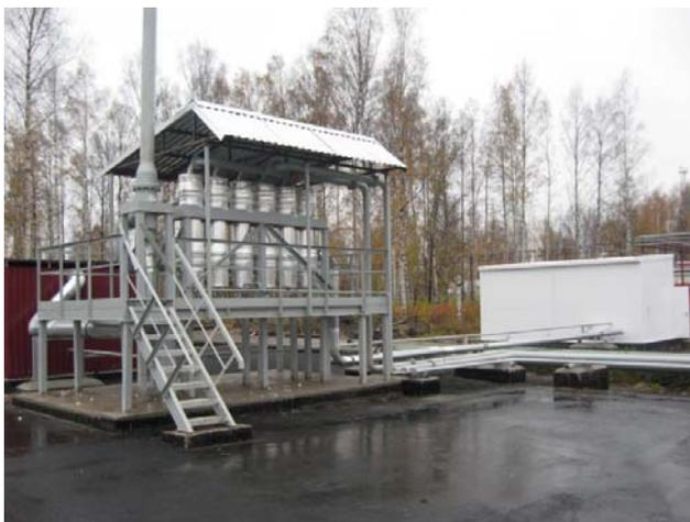
Рис.1. ККР 500 ТУ 3614-001-53976876-2009, производительность 500 м<sup>3</sup>/час. Санкт-Петербург, нефтебаза «Ручьи», ПТК. АСН, работа в одной установке с двумя паровоздушными потоками различного состава.
