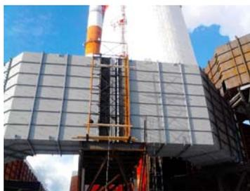
Компенсаторы газоходов водогрейных и энергетических котлов
