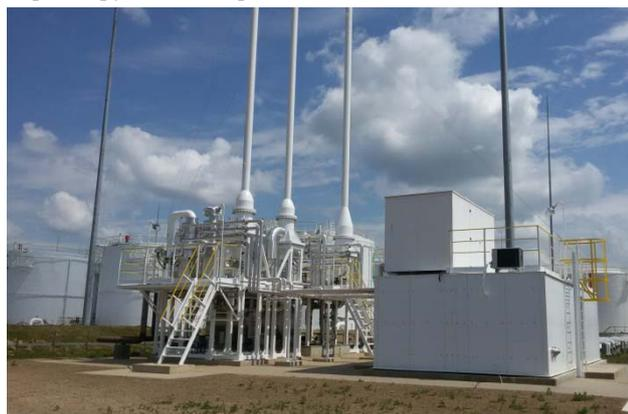
Рис.24. ККР 1200 ТУ 3614-001-53976876-2009, номинальная производительность 1200 м<sup>3</sup>/час. Фаниполь, РБ. Одновременная и независимая рекуперация паров автомобильных бензинов при больших и малых дыханиях резервуарного парка и при работе АСН в автоцистерны.
