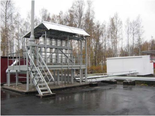
Рис.19. ККР 500 ТУ 3614-001-53976876-2009, производительность 500 м<sup>3</sup>/час. Санкт-Петербург, нефтебаза «Ручьи», ПТК. АСН, работа в одной установке с двумя паровоздушными потоками различного состава.
