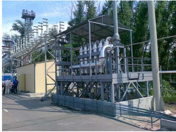
Рис.20. ККР 600 ТУ 3614-001-53976876-2009, номинальная производительность 600 м<sup>3</sup>/час. Ростов-на-Дону, причальный комплекс, Ростовский филиал Новошахтинского завода нефтепродуктов. Рекуперация паров прямогонного бензина при загрузке танкеров.
