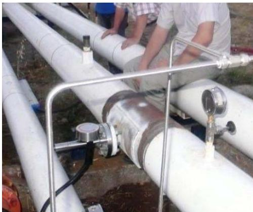
Рис. 2. Пример установки датчика L-Dens 4X7 на мультипродуктовую линию для детектирования нефтепродуктов.
