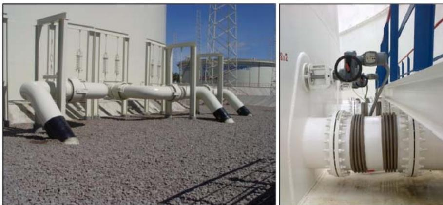
*Компенсация деформаций трубопроводов в резервуарных парках хранения нефти и мазута с применением сильфонных компенсаторов.*
