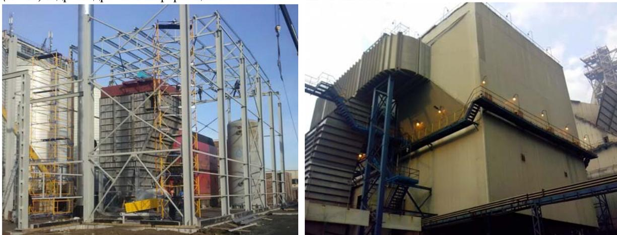
*Рис. 1. Монтаж рукавного фильтра (слева), электрофильтр на ОАО «ММК» (справа).*
