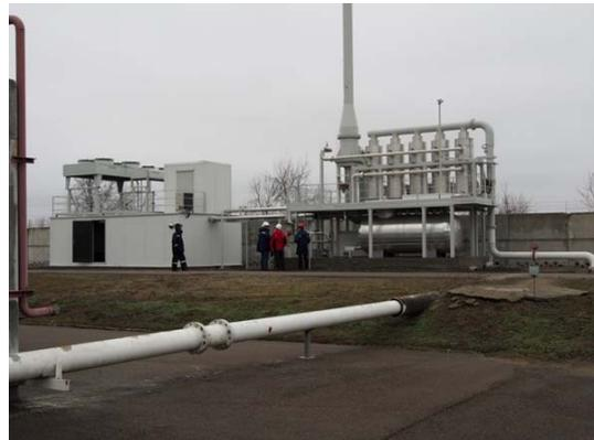
Рис.22. ККР 1000 ТУ 3614-001-53976876-2009, номинальная производительность 1000 м<sup>3</sup>/час. Азов, терминал нефтепродуктов, ЗАО «Азовпродукт». Рекуперация паров прямогонного бензина при больших и малых дыханиях резервуарного парка и при загрузке танкера.
