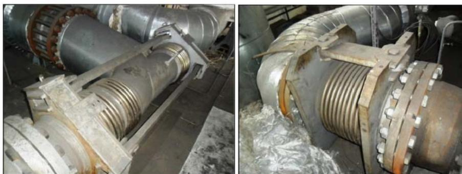
*Разгруженный сильфонный компенсатор с отводом DN 300; 1,6 МПа и сдвиговой сильфонный компенсатор DN 250; 1,6 МПа в обвязке насосов на ТЭЦ.*
