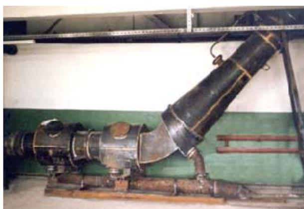
Рис. 5. ГОУ производительностью 8000 м<sup>3</sup>/час индукционной печи для плавки цветных металлов г. Кольчугино
