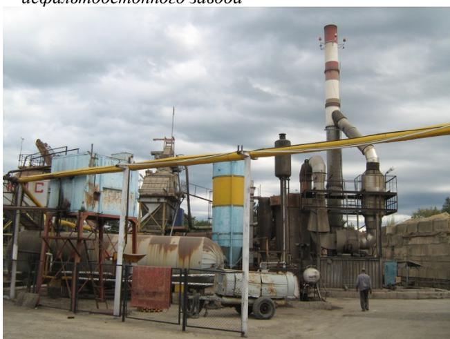
Рис. 4. ГОУ для очистки газов из сушильного барабана асфальтобетонного завода (г. Адлер, в работе с 1990 г.)
