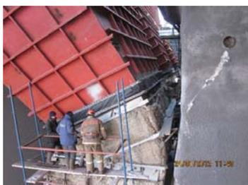
Компенсаторы Электрофильтра ALSTOM
