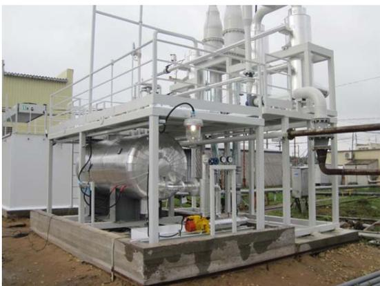
Рис.23. ККР 300 ТУ 3614-001-53976876-2009, номинальная производительность 300 м<sup>3</sup>/час. Гатчина, компания ЗАО «ЛВЖ-701». Одновременная и независимая рекуперация паров прямогонного бензина при больших и малых дыханиях резервуарного парка и при работе АСН в автоцистерны.
