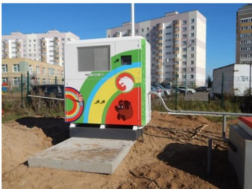
Рис.25. ККР 30М ТУ 3614-001-53976876-2014, номинальная производительность 30 м<sup>3</sup>/час. Казань, АЗС группы компаний «Транзит Сити». Рекуперация паров автомобильных бензинов при больших дыханиях резервуарного парка АЗС.
