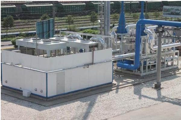
Рис.21. ККР 3000 ТУ 3614-001-53976876-2009, номинальная производительность 3000 м<sup>3</sup>/час. Новороссийск, Новороссийский мазутный терминал. Очистка паровоздушного потока при большом дыхании резервуаров.
