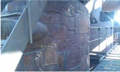
Рис.7 Абразивный износ корпуса циклона ЦН-15 (участок за входным патрубком)
