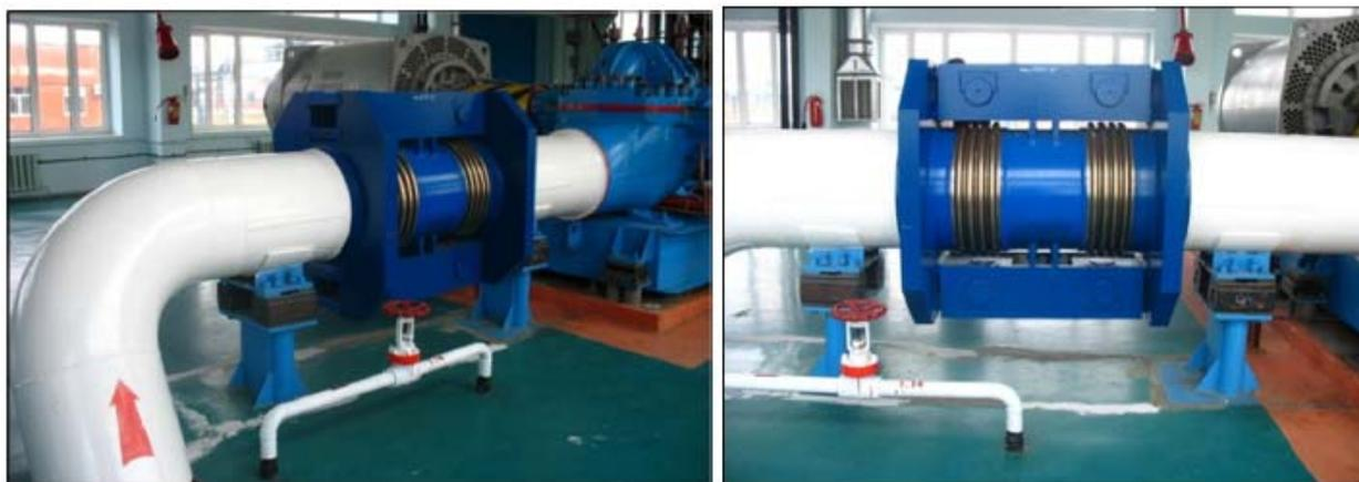
*Сдвиговые сильфонные компенсаторы DN 700, 7,5 МПа в обвязке нефтеперекачивающих насосов.*
