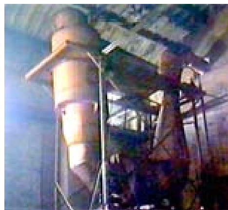
Рис. 3. ГОУ для очистки газов отходящих от установки обжига цветного вторсырья
