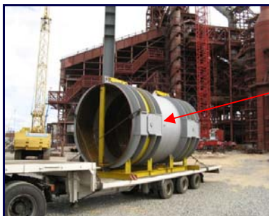
Компенсатор DN 2700 на сруббер домны Новолипецкого металлургического комбината
