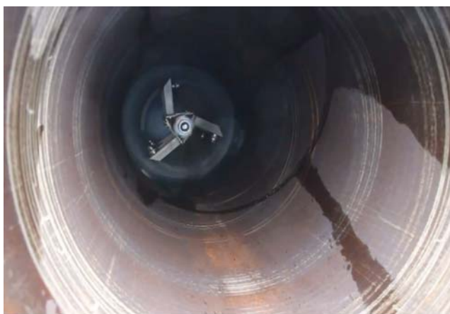
Рис. 2. Прочистка – Степень чистоты по ISO 8501-1 SA1-2,5
