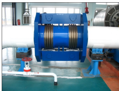
Сдвиговые сильфонные компенсаторы DN 700, 7,5 МПа в обвязке нефтеперекачивающих насосов.
