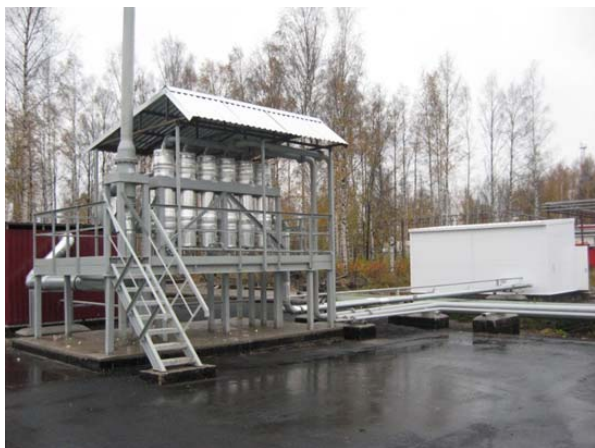
Рис.19. ККР 500 ТУ 3614-001-53976876-2009, производительность 500 м 3 /час. Санкт-Петербург, нефтебаза «Ручьи», ПТК. АСН, работа в одной установке с двумя паровоздушными потоками различного состава.
