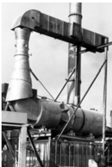
Рис. 2. ГОУ для очистки газов из сушильного барабана асфальтобетонного завода
