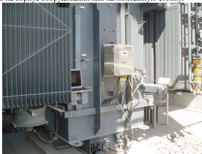
Рис. 6. Пример установки Calisto
