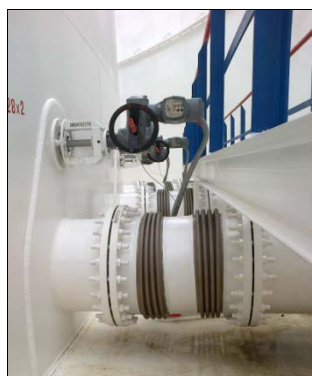
Компенсация деформаций трубопроводов в резервуарных парках хранения нефти и мазута с применением сильфонных компенсаторов.
