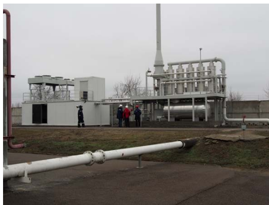
Рис.22. ККР 1000 ТУ 3614-001-53976876-2009, номинальная производительность 1000 м 3 /час. Азов, терминал нефтепродуктов, ЗАО «Азовпродукт». Рекуперация паров прямогонного бензина при больших и малых дыханиях резервуарного парка и при загрузке танкера.
