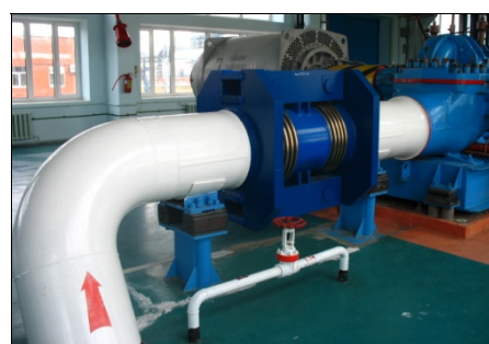
Сдвиговые сильфонные компенсаторы DN 700, 7,5 МПа в обвязке нефтеперекачивающих насосов.
