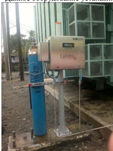
Рис. 5. Пример установки Calisto 9
