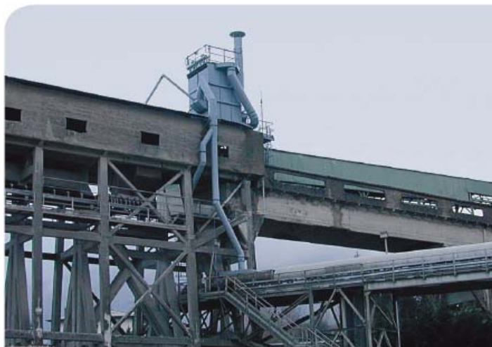
Рис. 4. Обеспыливание ленточных конвейеров
