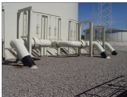
Компенсация деформаций трубопроводов в резервуарных парках хранения нефти и мазута с применением сильфонных компенсаторов.
