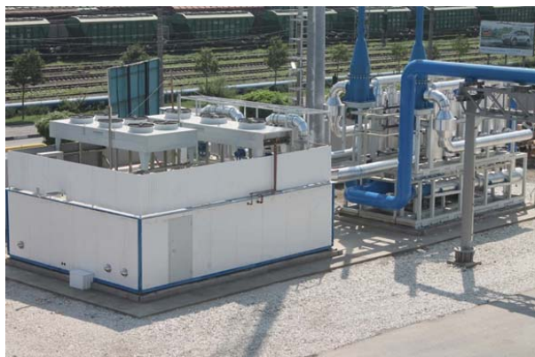
Рис.21. ККР 3000 ТУ 3614-001-53976876-2009, номинальная производительность 3000 м 3 /час. Новороссийск, Новороссийский мазутный терминал. Очистка паровоздушного потока при большом дыхании резервуаров.
