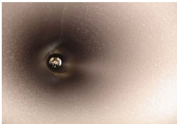
Рис. 4. Труба с внутренним МПП
