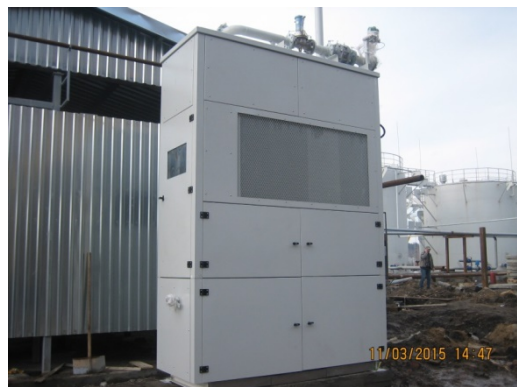
Рис.26 ККР 100М ТУ 3614-001-53976876-2014, номинальная производительность 100 м 3 /час. Иваново, ОАО «Ивхимпром». Рекуперация паров бензинов.
