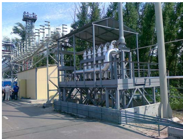
Рис.20. ККР 600 ТУ 3614-001-53976876-2009, номинальная производительность 600 м 3 /час. Ростов-на-Дону, причальный комплекс, Ростовский филиал Новошахтинского завода нефтепродуктов. Рекуперация паров прямогонного бензина при загрузке танкеров.
