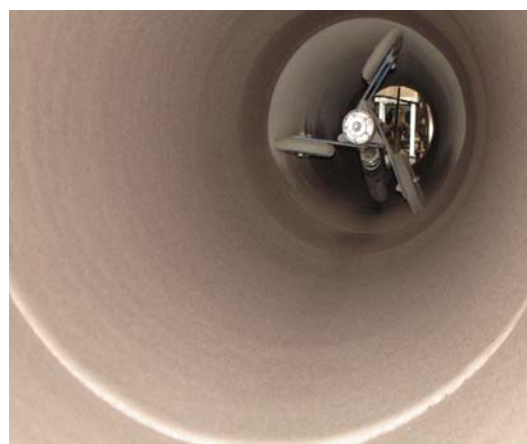
Рис. 3. Нанесение Минерально-полимерного покрытия
