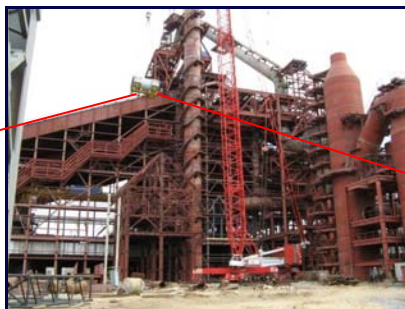
Компенсатор DN 2700 на сруббер домны Новолипецкого металлургического комбината
